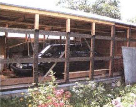
Перед монтажом асбоцементных плит стойки и продольные перекладины были покрыты рубероидом.
