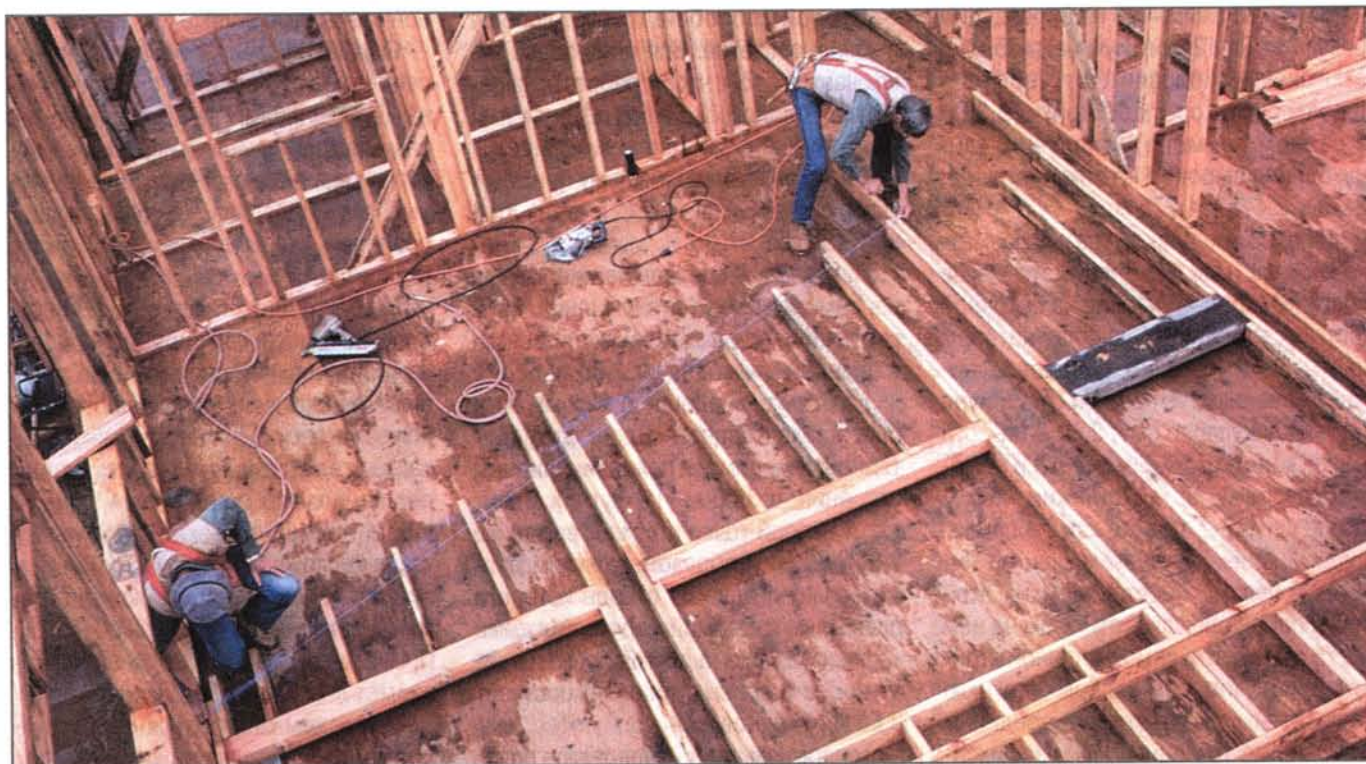
Сборка каркаса. Остаётся подрезать стойки и другие вертикальные элементы каркаса и прибить верхнюю обвязку.
