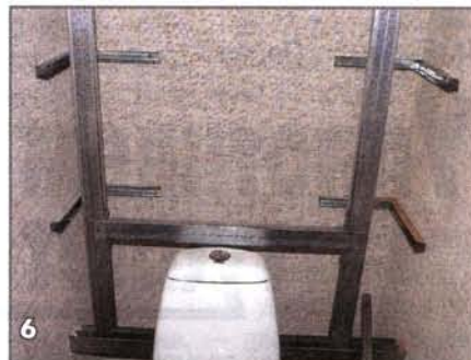
6 Жёсткость каркаса можно увеличить с помощью горизонтальных вставок.
