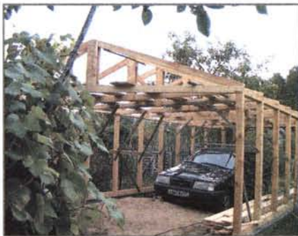
Каркас гаража закончен.
