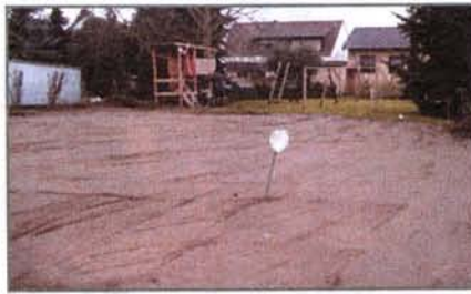
Строительная площадка после засыпки грунтом бывшего подвала и уплотнения грунта.
