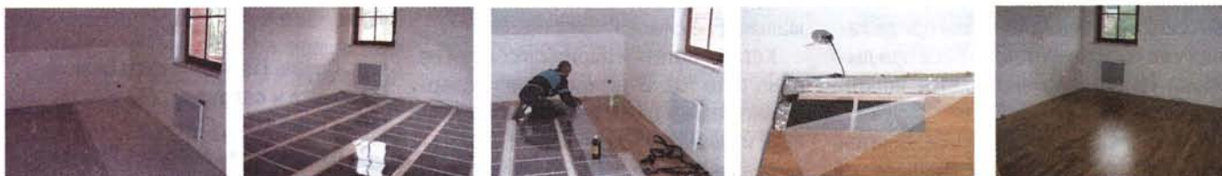
Этапы укладки Ecofilm F под ламинатный пол.
