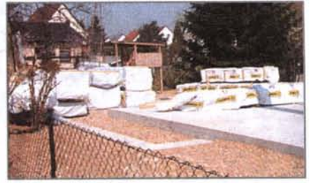
Доставка материалов на строительную площадку.
