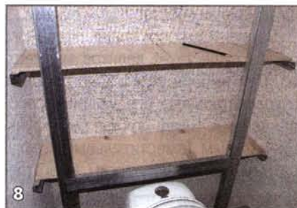
8 Полки изготовлены из фанеры и прикреплены саморезами к профилю.
