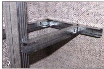
7 К стене профиль крепим шурупами.
