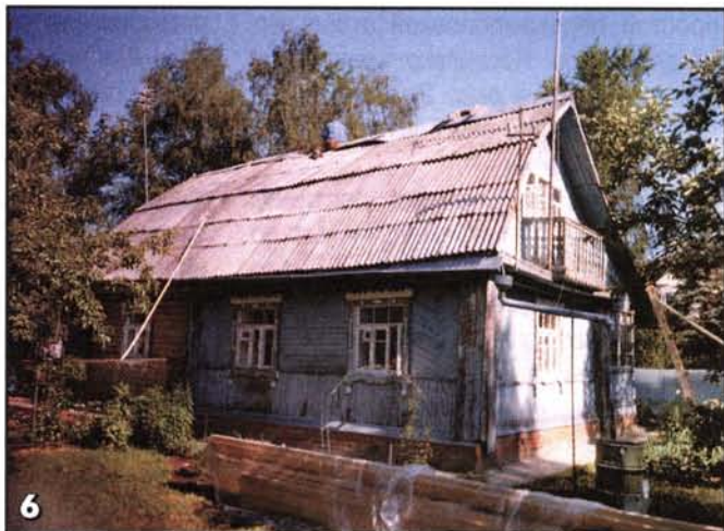
Дом до реконструкции крыши.
