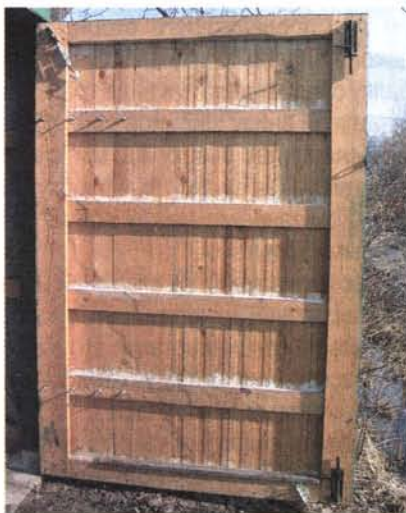
Проволочные тяги с талрепами для корректировки геометрии створок ворот — временное решение.
