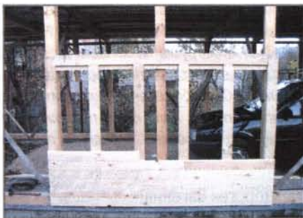
При отсутствии на участке ровной поверхности, воротные створки можно собирать на стойках каркаса.
